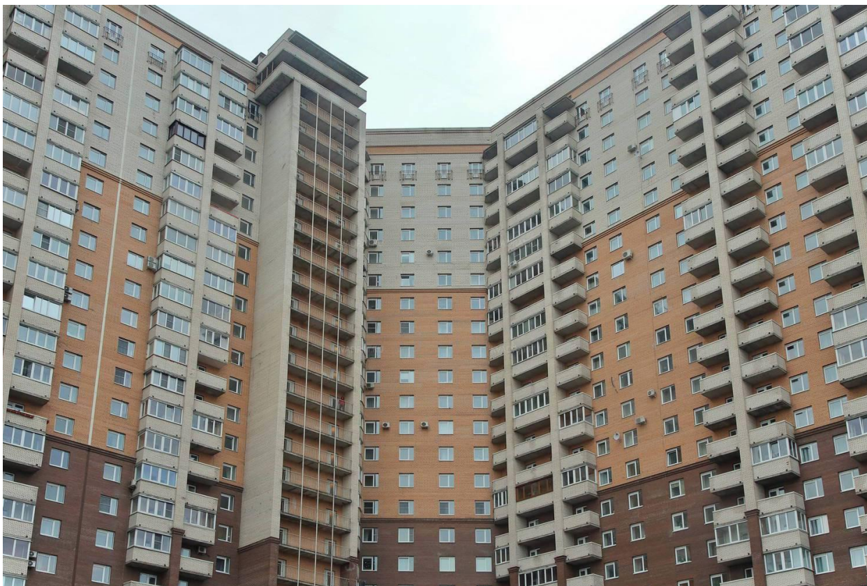
Фото 5 Арендный дом на Коломяжском, 15
